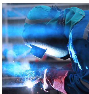
2) 将管道穿舱件/船用地漏焊接到甲板/舱壁
